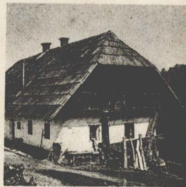
Značilna pohorska hiša. Zgrajena je iz kamna in lesa, pokrita pa s slamo ali škodlami. Okna so majhna, zato je v njej pozimi toplj, poleti pa hladno.
